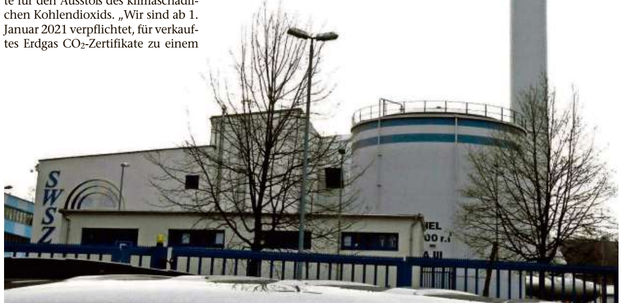
Firmensitz der Stadtwerke Suhl/Zella-Mehlis (SWSZ) am Fröhlichen Mann. Von hier werden Gas, Strom und Fernwärme in die Region verteilt.
