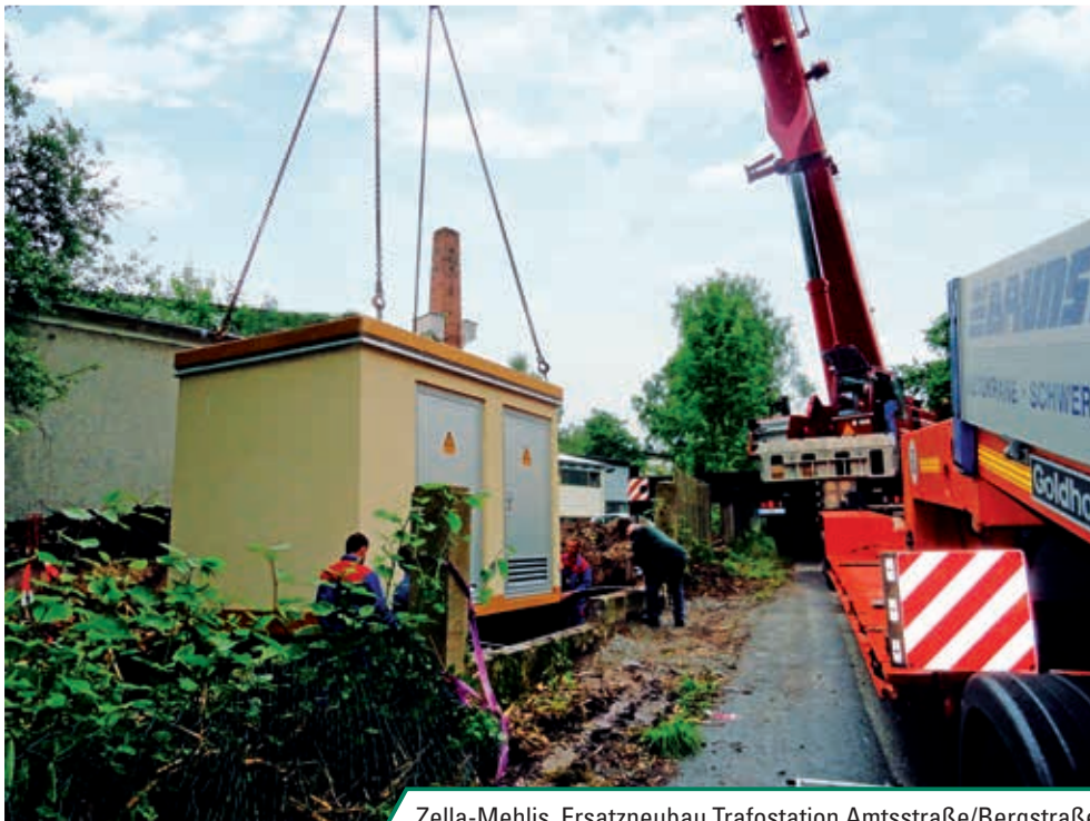
Zella-Mehlis, Ersatzneubau Trafostation Amtsstraße/Bergstraße
