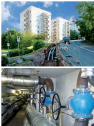
Verlegung von zwei Fernwärmeverbindungsleitungen DN 200 zwischen Sammelkanal Karl-Marx-Straße und Himmelreich
