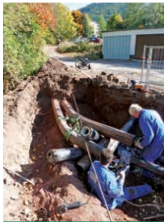
Neuverlegung einer Fernwärmeleitung am Garagenkomplex Schwarzwasserweg
