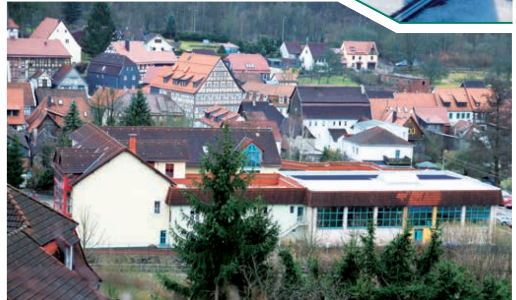
Die dritte Photovoltaik-Anlage auf dem Turnhallendach der Grundschule in Heinrichs liefert seit Ende November 2012 „grünen Strom“ – Anlagenleistung 21,07 kWp, Jahreserzeugung ca. 17.800 kWh
