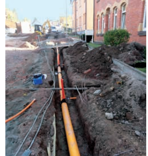
Zella-Mehlis, Neuverlegung der Mitteldruckgasleitung und aller Hausanschlüsse in der Hauptstraße
