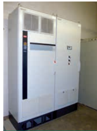
Austausch eines Frequenzumrichters für den Betrieb der Heiznetzumwälzpumpen im HKW Bohrhügel
