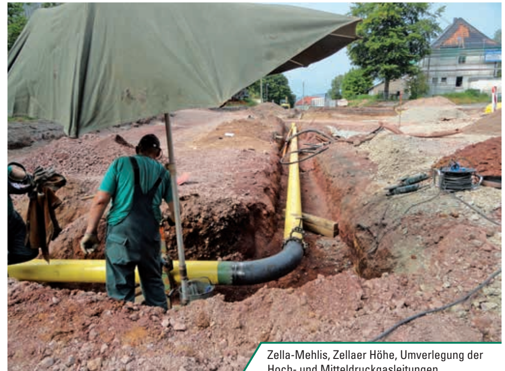
Zella-Mehlis, Neuverlegung der Mitteldruckgasleitung und aller Hausanschlüsse in der Hauptstraße
