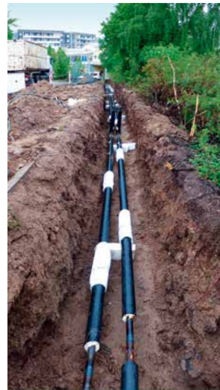
Neuanschluss des „Rennsteigkarree“ in Suhl-Nord
