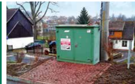
Sanierung Friedhofsweg, Zella-Mehlis Strom: Verlegung von 100m Hauptleitung und fünf Hausanschlüssen Gas: Aufstellen einer neuen Gasdruckregelanlage, Verlegen von 100m ND-Gasleitung und fünf Hausanschlüssen
