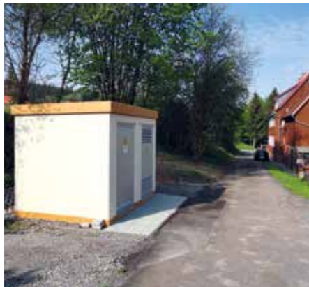
Errichtung von zwei modernen Ortsnetzstationen und Rückbau der Altanlagen in Suhl-Dietzhausen sowie Rekonstruktion des Mittel- und Niederspannungsnetzes mit Verlegung von 1.800m MS- und 2.100m NS-Kabel.
