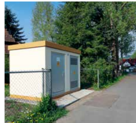
Errichtung von zwei modernen Ortsnetzstationen und Rückbau der Altanlagen in Suhl-Dietzhausen sowie Rekonstruktion des Mittel- und Niederspannungsnetzes mit Verlegung von 1.800m MS- und 2.100m NS-Kabel.
