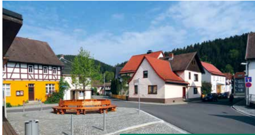
Gemeinschaftsmaßnahme „Neugestaltung Dorfplatz in Suhl-Mäbendorf“ durch die Stadt Suhl/ZWAS/SWSZ Netz / Kabel-Deutschland u. a. mit Rückbau der Freileitungsanlage und Verlegung von 380m Niederspannungskabel
