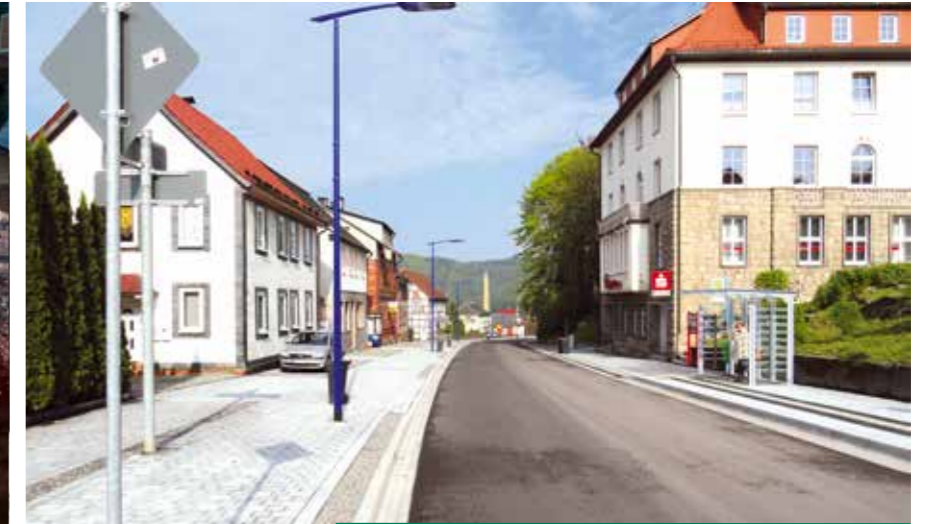
Sanierung der Hauptstraße 4.BA in Zella-Mehlis, Verlegung von 260m Mitteldruckgasleitung HDPE DN 160 und Neuverlegung von neun Hausanschlüssen
