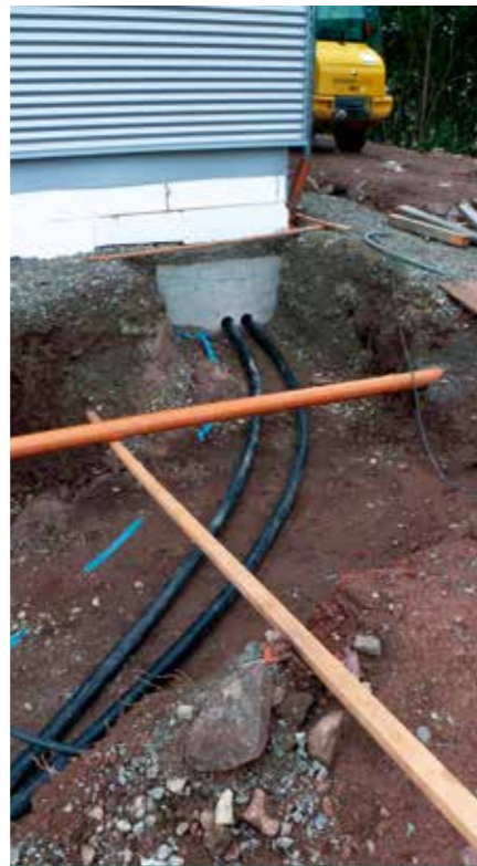
Fernwärmeanschluss für den Servicepunkt der Sparkasse, Suhl, Nexö-Straße
