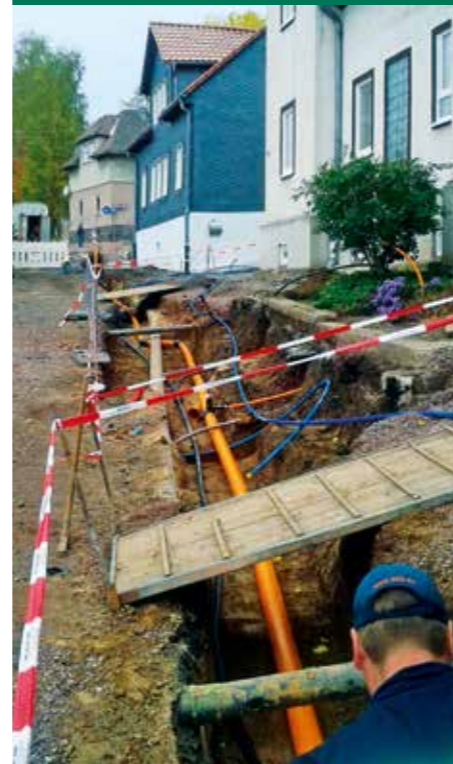
Sanierung Friedhofsweg, Zella-Mehlis Strom: Verlegung von 100m Hauptleitung und fünf Hausanschlüssen Gas: Aufstellen einer neuen Gasdruckregelanlage, Verlegen von 100m ND-Gasleitung und fünf Hausanschlüssen
