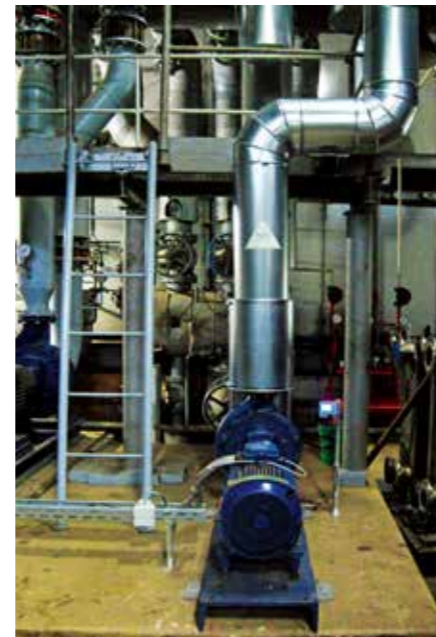
Installation einer neuen Umwälzpumpe für den Sommerbetrieb im Wohngebiet Suhl-Nord.
