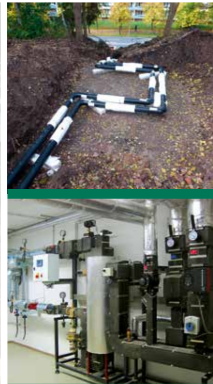
Anschluss des Neubaus der VS-Seniorenresidenz Suhl, Straße am Bahnhof
